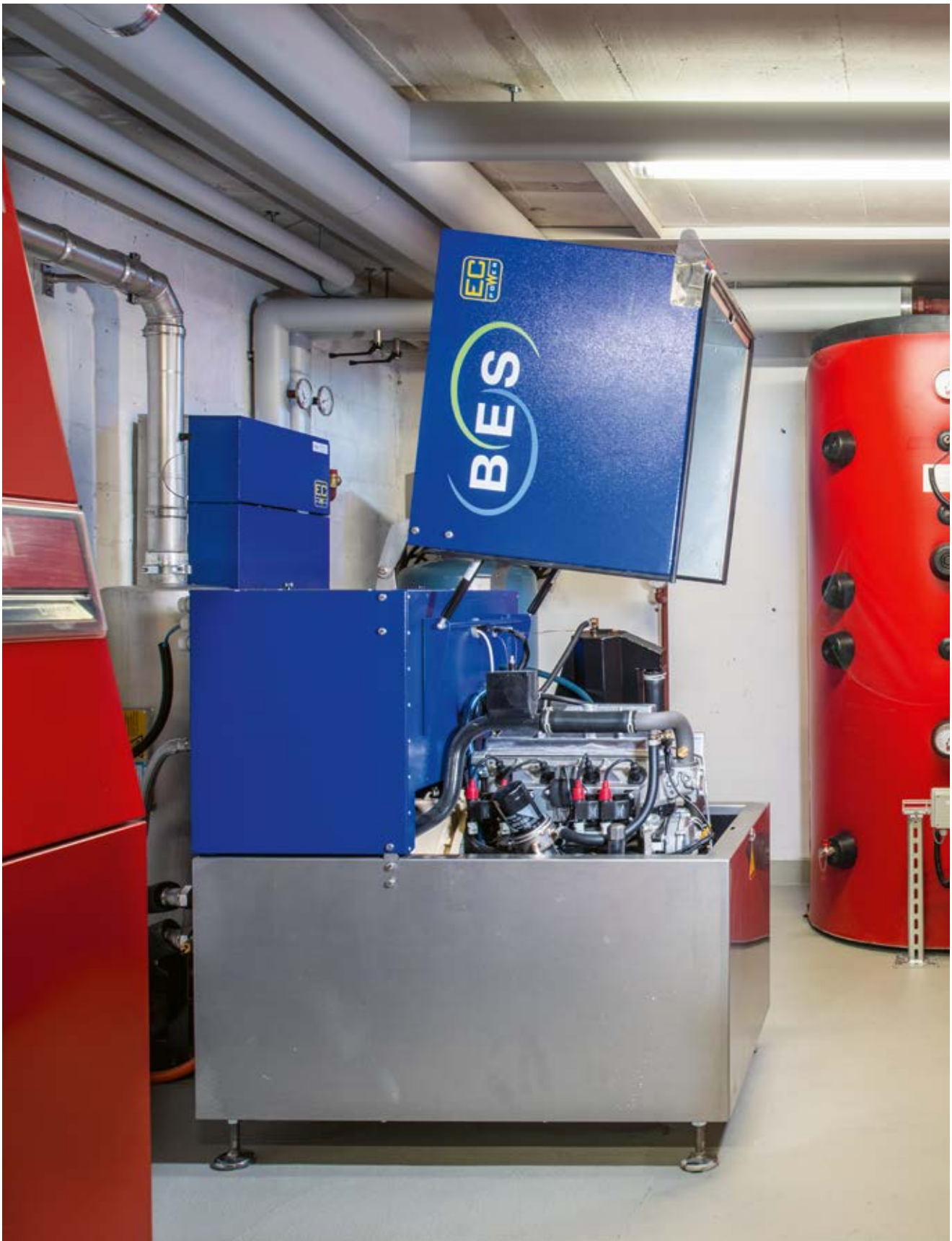
↑ In St.Gallen effizient eingesetzt: Ein Blockheizkraftwerk an der Letzistrasse erzeugt aus Erd- und Biogas elektrische Energie und Wärme.
